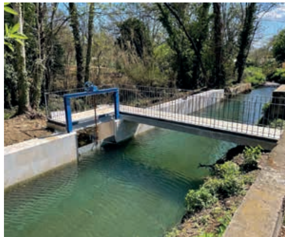
Les obres han permès reparar el sobreeixidor del canal de regants del riu Terri, a la zona de Mas Riera.
