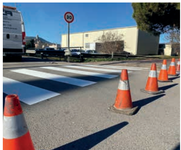
Repintada d'un pas de vianants de la carretera de Vilavenut
